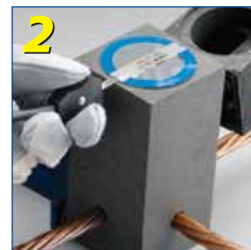
2 Sluit de kabel-aansluitklem aan op de ontstekingsstrip
