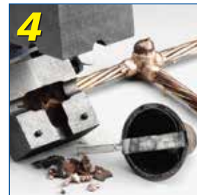
4 Open de mold en verwijder de gebruikte laspoeder-cup, er gelden geen speciale regels voor het afval
