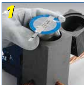
1 Plaats de CADWELD PLUS laspoeder cup in de mold
